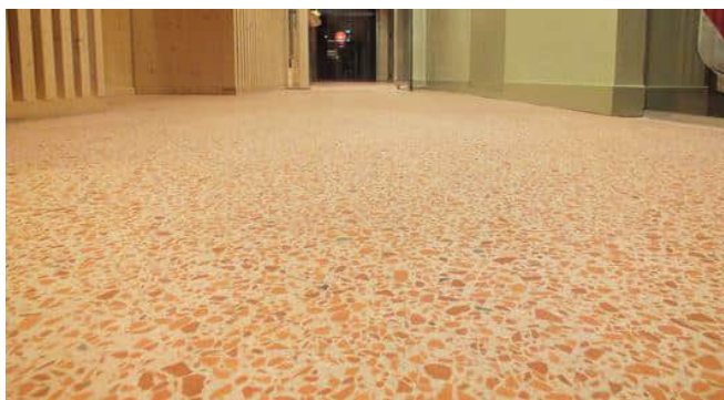
Terrazzo mit Ziegelbruch als Gesteinskörnung (terrazzo-hess.com)
