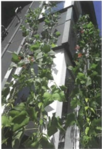
6 – An Seilen geführte Kletterpflanzen vor Glasfassaden bilden eine Synergie von Verschattung und Verdunstungskälte im Sommer, im Winter lassen sie die Sonne ungehindert passieren.
